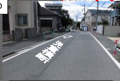
路面標示の新設
