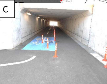
ラバーポールの設置
