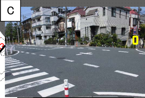
電柱幕の新設
