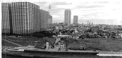
市川南ポンプ場建設工事
