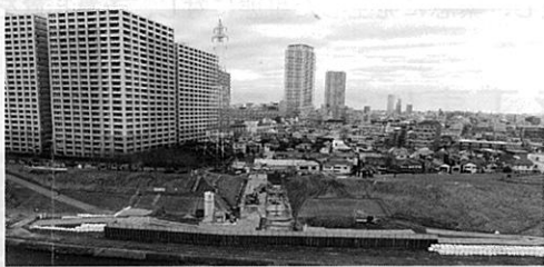
市川南ポンプ場建設工事
