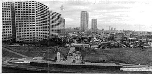
市川南ポンプ場建設工事
