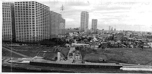
市川南ポンプ場建設工事
