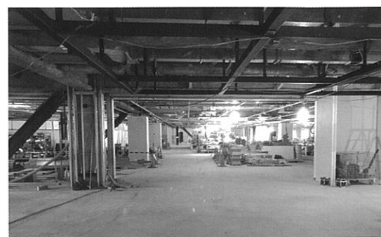
新第1庁舎 建物内部 工事現場写真(1月末日撮影)
