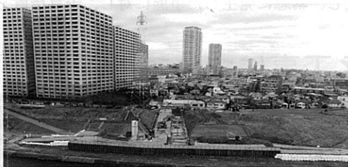
市川南ポンプ場建設工事
