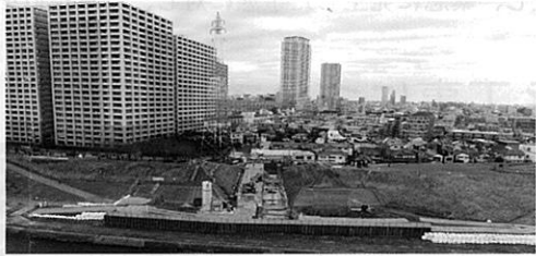
市川南ポンプ場建設工事
