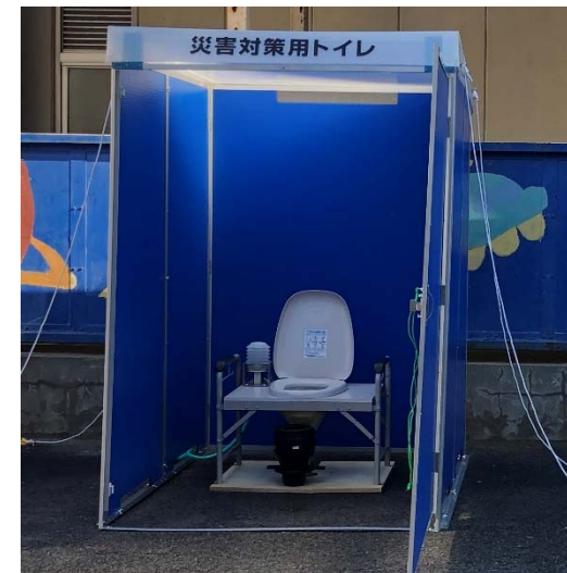
[マンホールトイレの設置] 4
