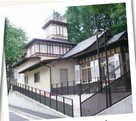
旧木内別邸の洋館部分を復元・再築した建物です。
