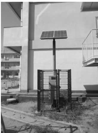
中山小学校の太陽光発電設備
