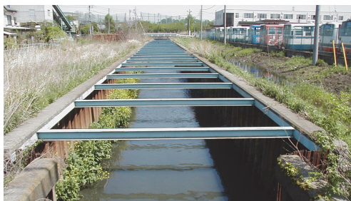
整備前：鋼矢板護岸
