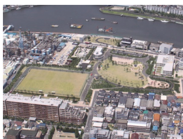
上空から見た広尾防災公園
