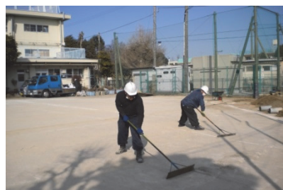
校庭表土の除去
