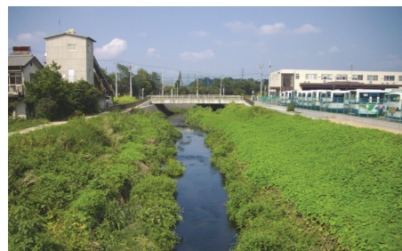
整備後：多自然型護岸
