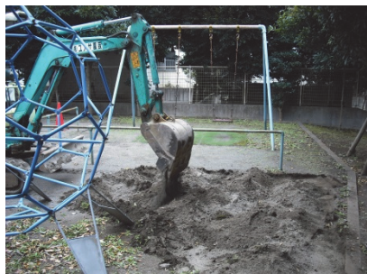
重機による土の掘り起こし
