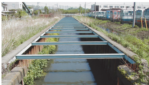
整備前：鋼矢板護岸
