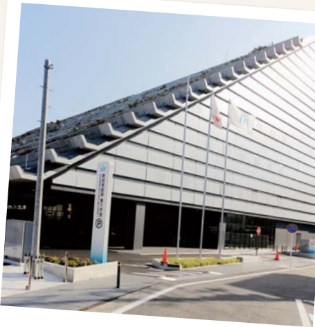
北側から見た第1庁舎
