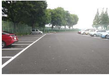
② 公園内の駐車場
