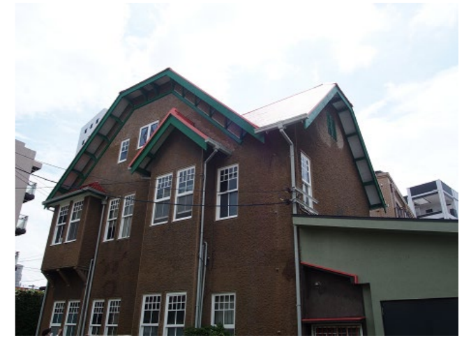
北西からの外観
