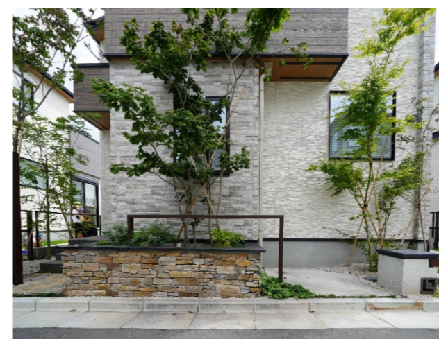
道路沿いのフレームと緑が映える外壁
