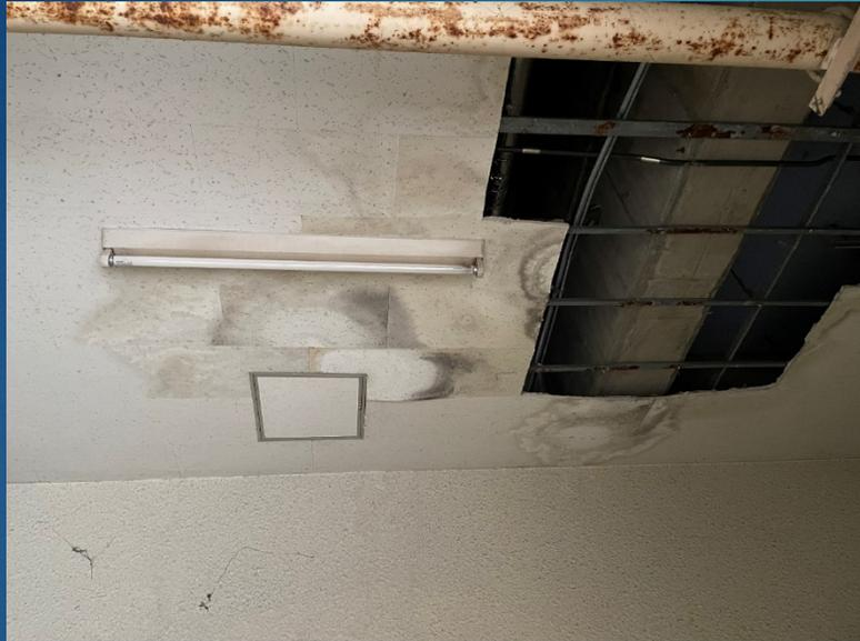
雨漏りの影響で、天井が剥がれている。
