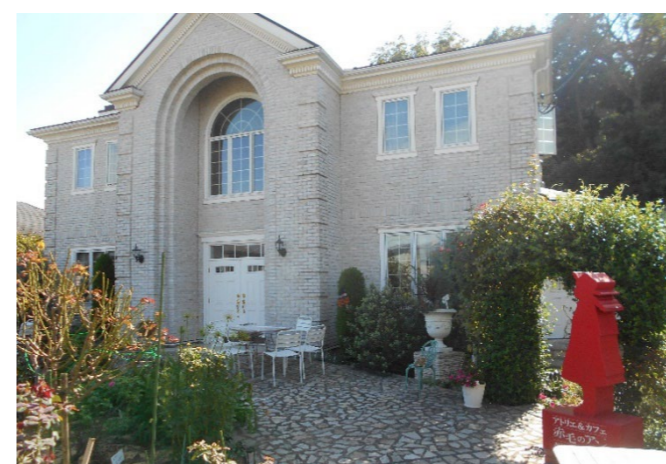
建物(カフェの入り口側)
