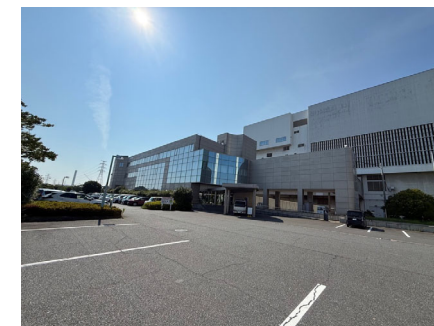
⑫既存建物_管理棟
