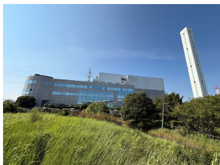
⑬計画敷地から管理棟
