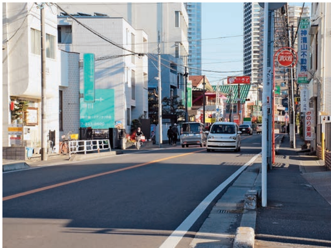
道路の拡幅が望まれる国道14号(写真:平田町会事務所前)
