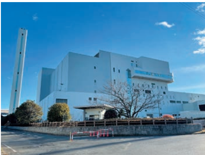
クリーンセンターの外観
