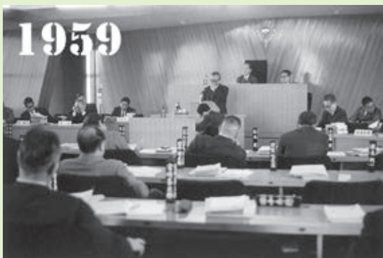
1959 建て替え後の庁舎（旧第一庁舎）に置かれた議場
