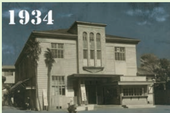
1934 市制施行 その翌年に完成した市庁舎
