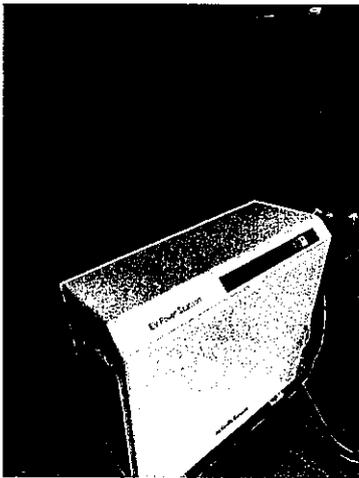
2階に設置された災害時の給電装置。この施設には太陽光パネルは設置されていない。庁有車のリーフを使って給電すれば1日対応ができるそうだ。2階に設置されているのは、1階が水に浸かるような災害時も安心して使えるからだそうだ。
