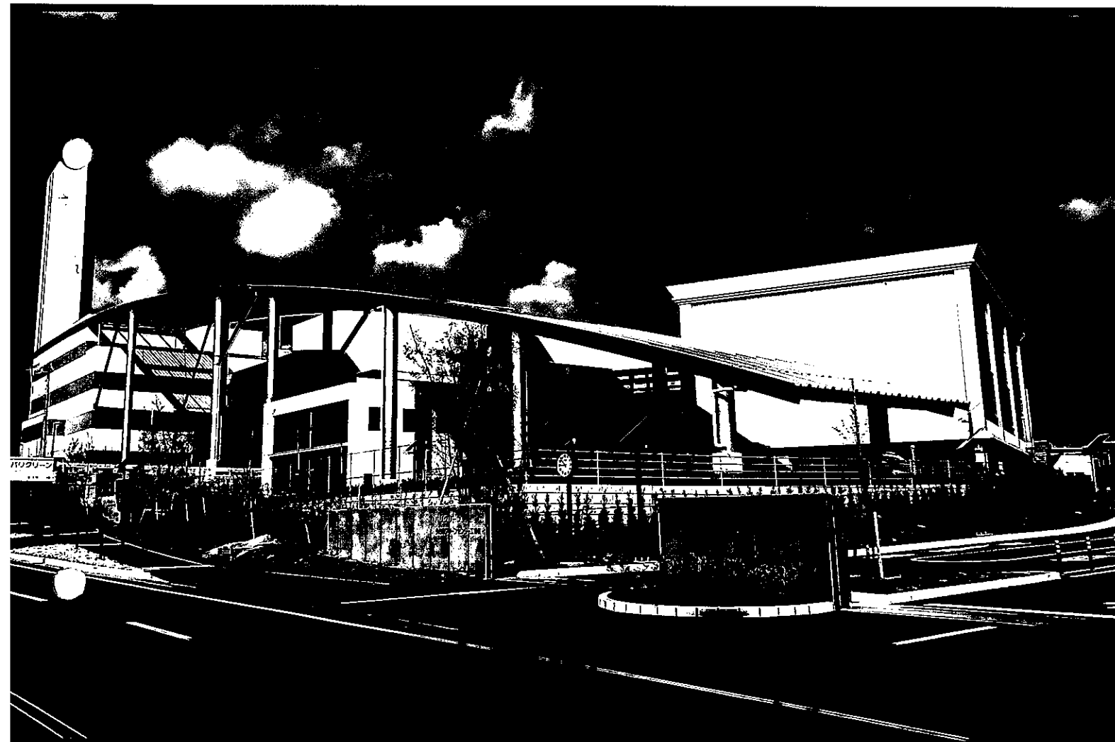
今治市クリーンセンターバリクリーン全景
