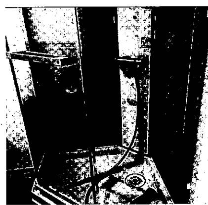
市長室に設置されたシャワーユニット。写真は建設中(市川市提供)
