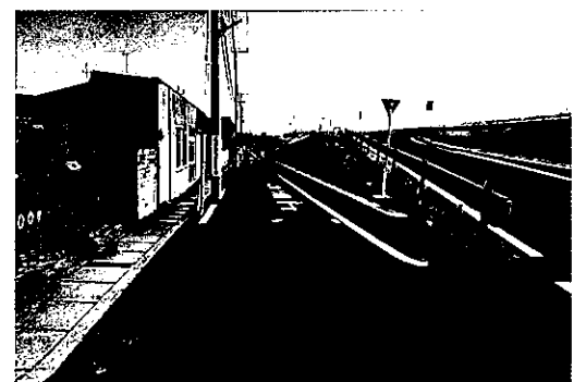
▲ 稲荷木地区 河川区域内道路
