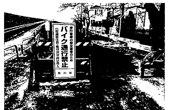
▲ 大洲地区の江戸川土手沿いの河川区域内道路
