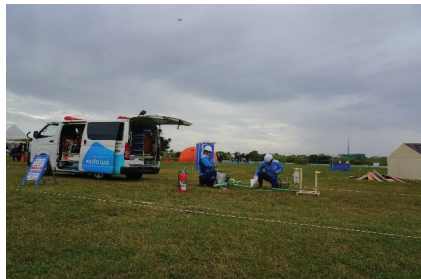
ライフライン復旧(京葉ガス)
