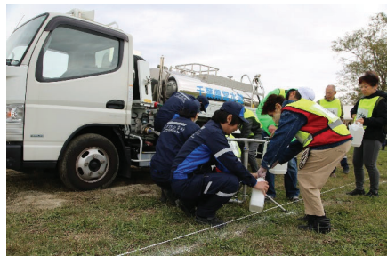
ライフライン復旧(水道事務所)
