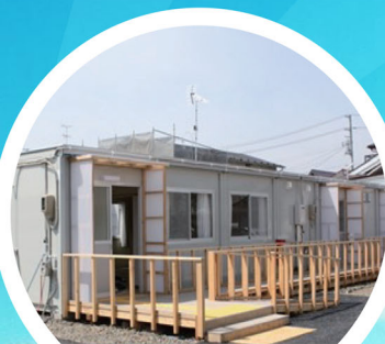
仮設住宅建設用地
