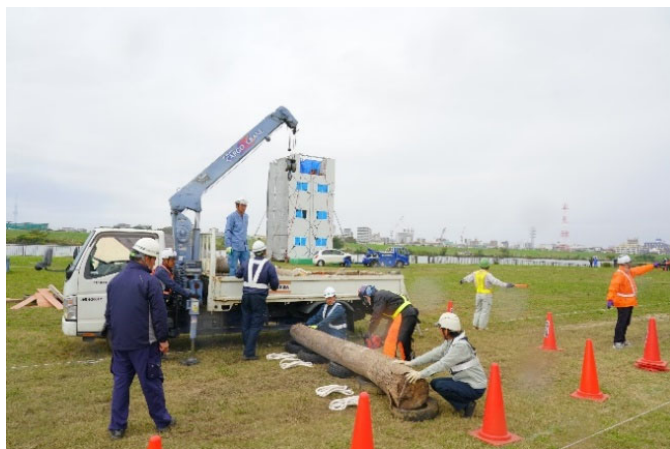
道路啓開（造園業）
