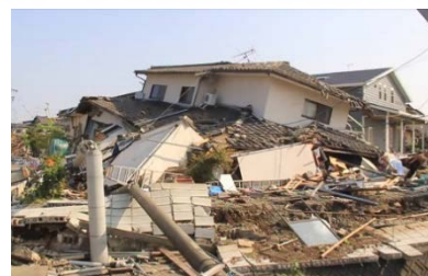
倒壊した家屋 出典: 熊本県宇土市(協定市)
