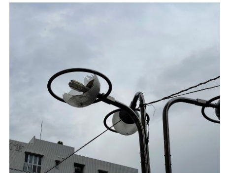
真間銀座通りの街路灯破損
