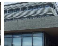
03：コンクリート打放し
