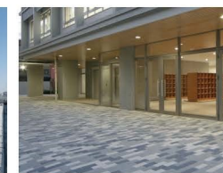
08：インターロッキングブロック舗装
