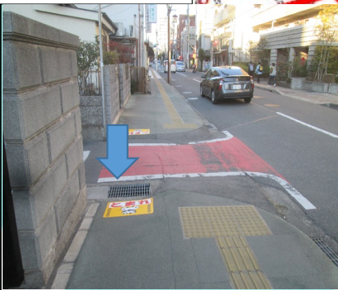
137 路面シール設置
