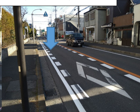
134 路面標示、外側線引き直し
