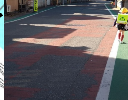
183 注意喚起看板設置
