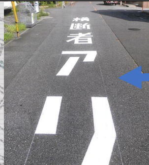
25 道路標示復旧
