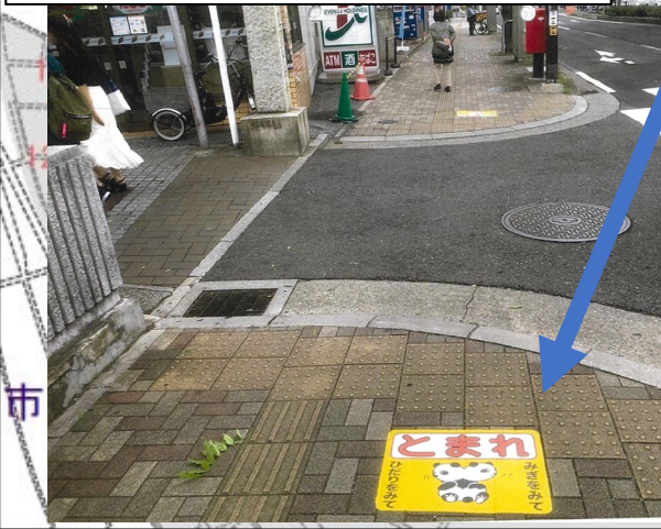
7 路面シール補修
