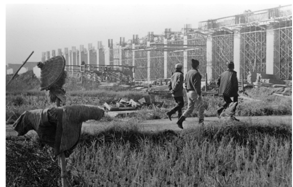
こうじ 行徳駅近くの東西線工事のようす （昭和42年）
