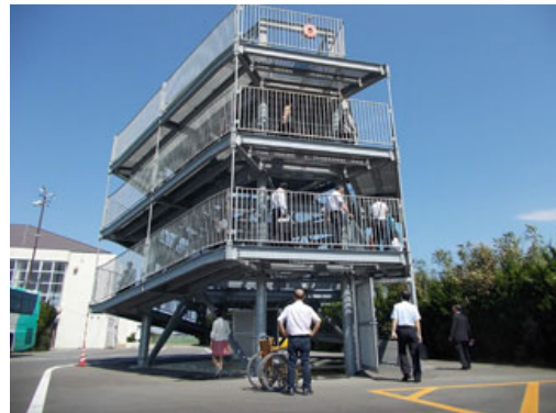
新しく作られた津波避難タワー
