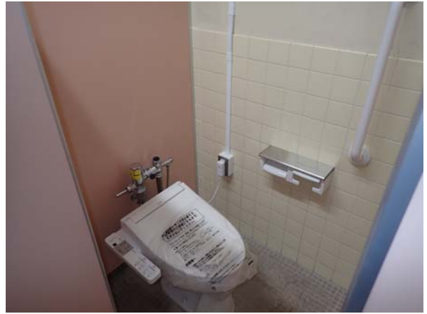
八幡小学校体育館トイレ
