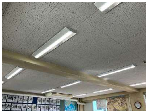
信篤小 LED 照明改修工事
