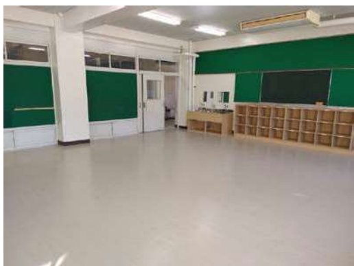
真間小 教室床等改修工事
