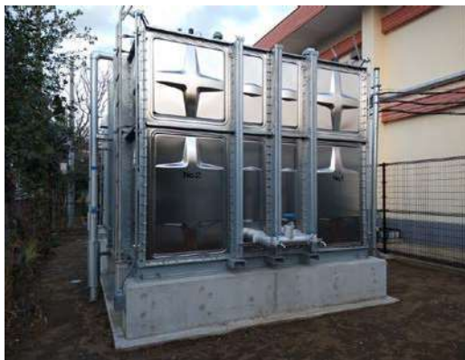
大和田小 受水槽等改修工事
