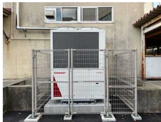
鬼高小 給食室冷暖房機設置工事
