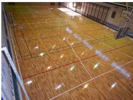
国府台小 屋内運動場改修工事
