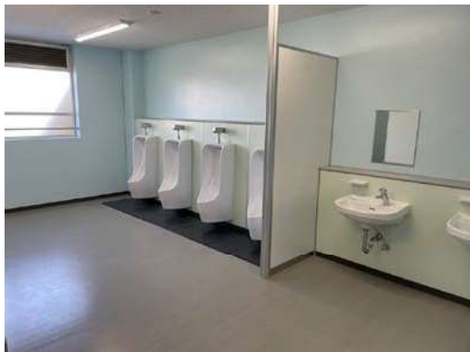
塩焼小 便所改修工事
