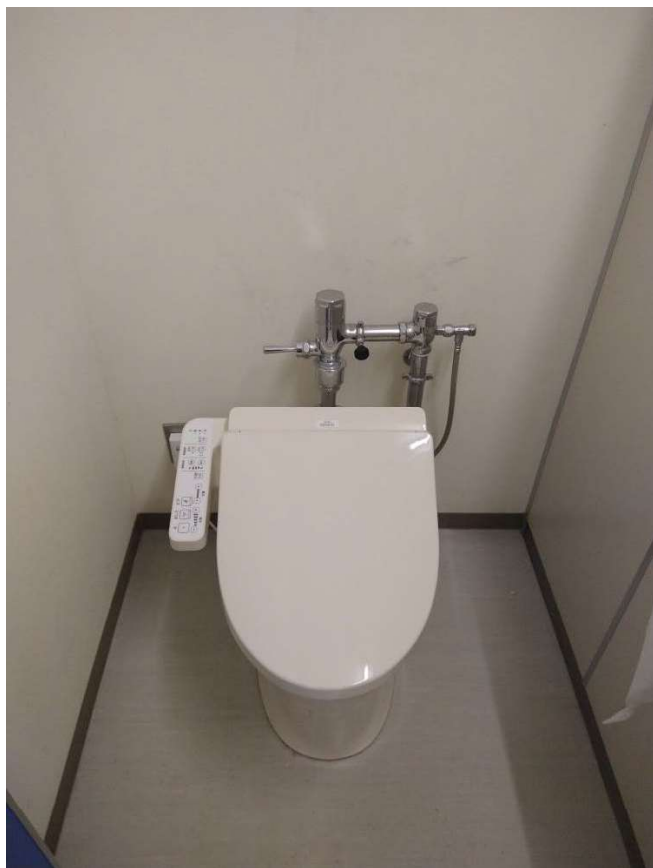
第四中学校 体育館トイレ改修修繕
