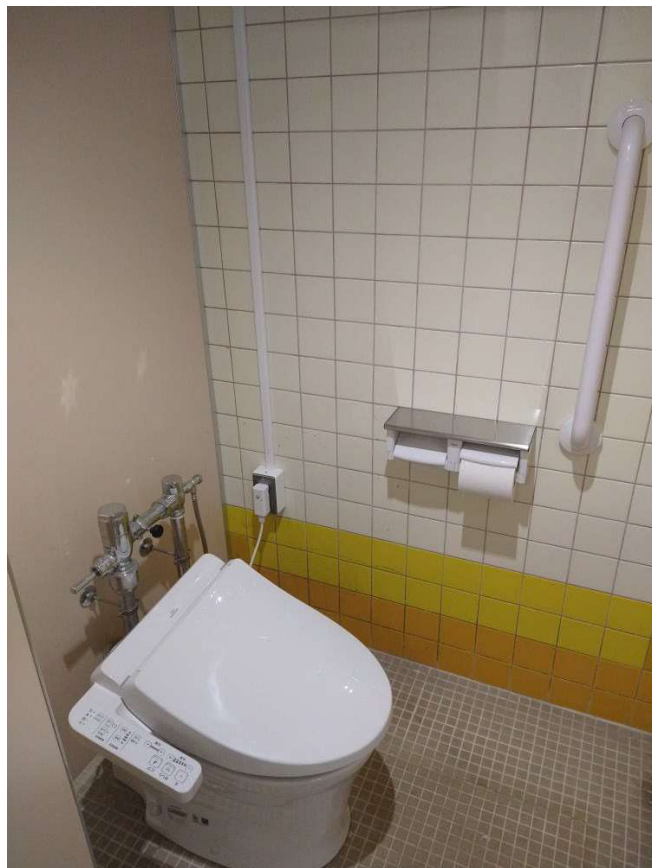
妙典中学校 体育館トイレ改修修繕
