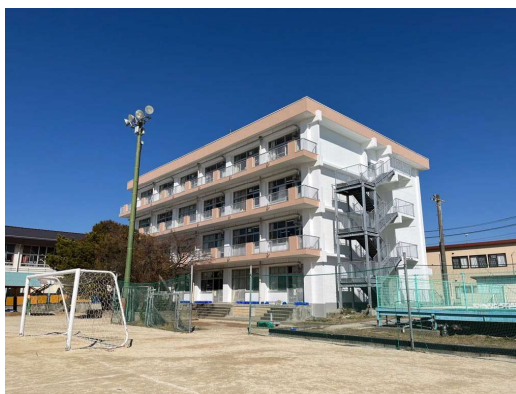
鬼高小 屋上防水及び外壁改修工事
