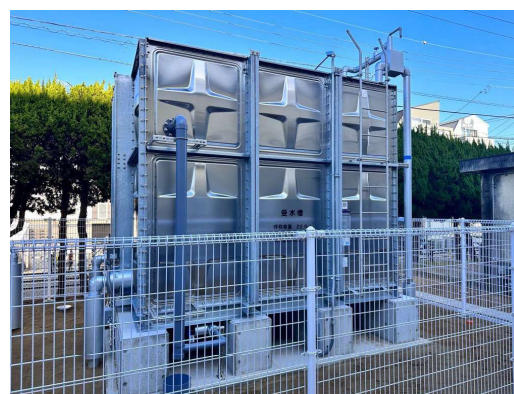
塩焼小 受水槽等改修工事
