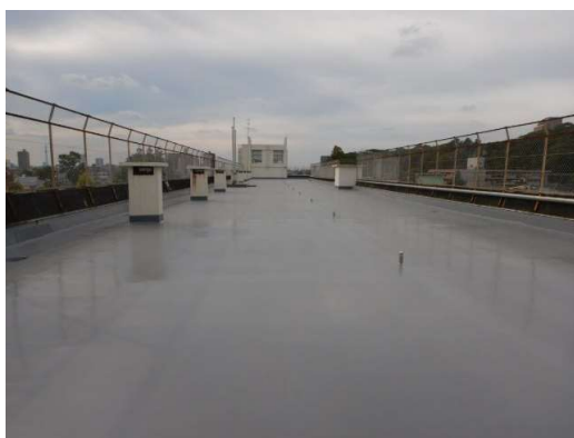
真間小 教室床及び屋上防水改修工事
