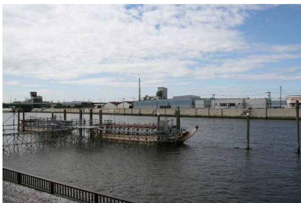
工事の完了後
