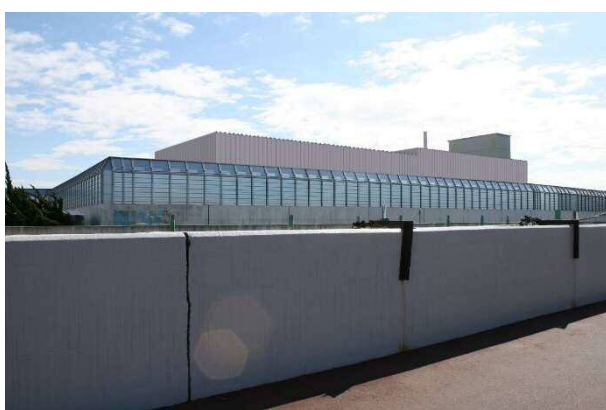
工事の完了後
