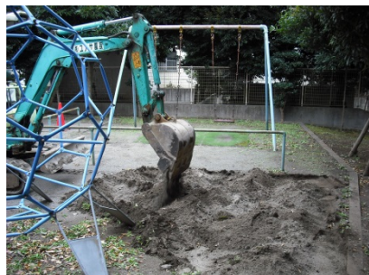
重機による土の掘り起こし
