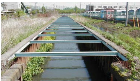
整備前：鋼矢板護岸
