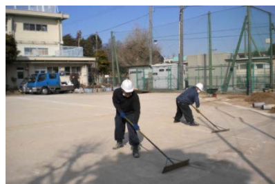
校庭表土の除去
