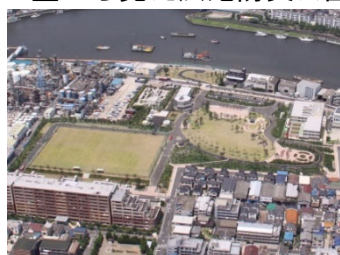
上空から見た広尾防災公園
