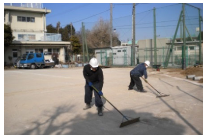
校庭表土の除去
