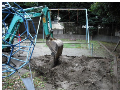
重機による土の掘り起こし
