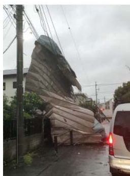
台風 15 号に伴う強風による被害（市川市）
