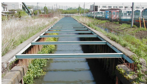
整備前：鋼矢板護岸
