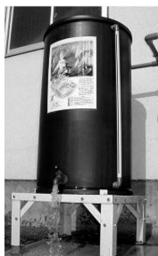
雨水貯留施設（雨どい取付型）
