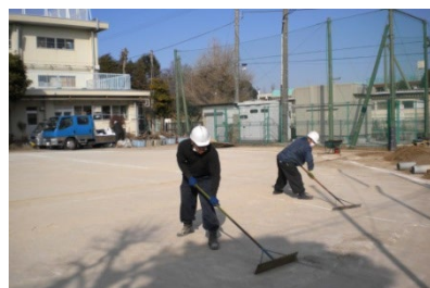
校庭表土の除去
