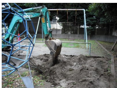
重機による土の掘り起こし
