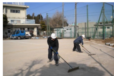
校庭表土の除去
