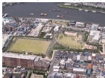
上空から見た広尾防災公園
