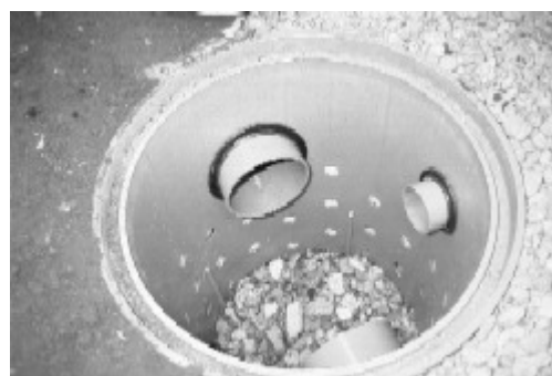
雨水浸透施設（浸透枳）
