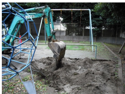
重機による土の掘り起こし
