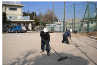
校庭表土の除去
