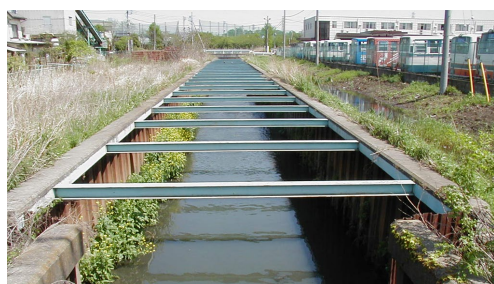
整備前：鋼矢板護岸
